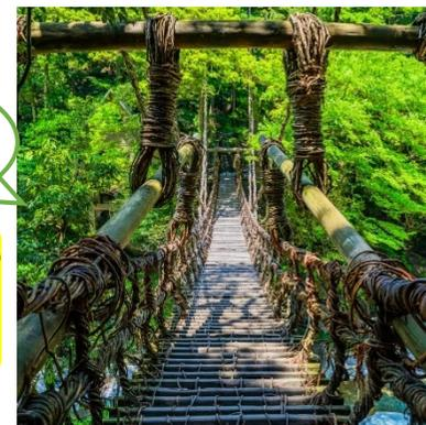
急流が白波を立てる祖谷川の渓流にかずら橋が架かっています。重さ約6トンのシラクチカズラを編み連ねて作られ3年ごとに架け替えが行われます。
